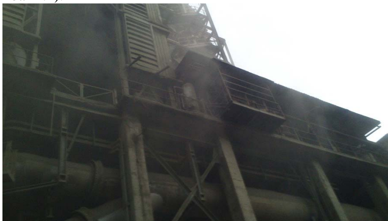
Gambar 4.2 Kondisi cooler setelah percobaan I
