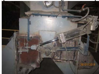
Gambar 6. Kondisi chasing yang belum dimodifikasi
