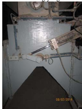
Gambar 7. Kondisi chasing setelah modifikasi
