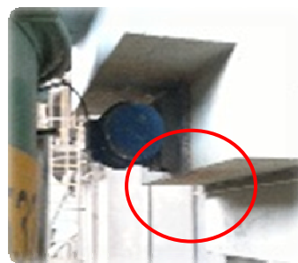
Gambar 9. Pemasangan Vibrator pada stepping chute jalur material reject
