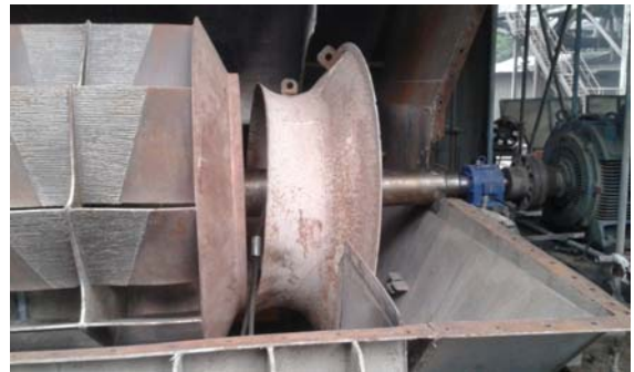
Gambar 4. Proses Instalasi EP Cooler Fan
