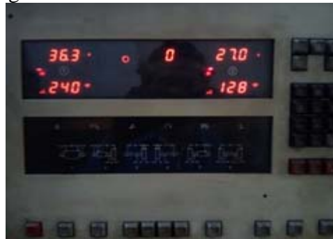
Gambar 7. Display monitor pada control cabinet hasil running pertama
