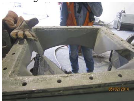
Gambar 1.Kondisi keausan chute bagian atas
